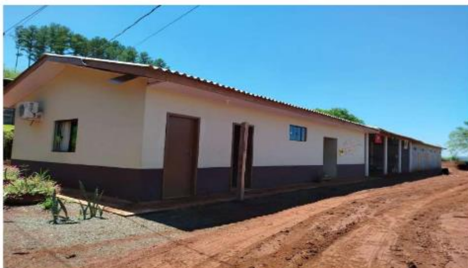
Fig. 10 - Nova estrutura da secretaria, cozinha, refeitório e cinco salas de aula.
